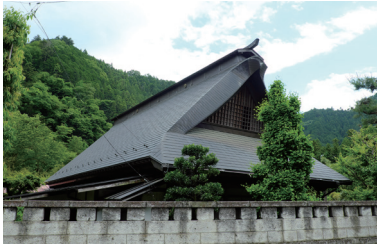
築150年の主屋 2階はかつて 養蚕部屋として利用されていた。
