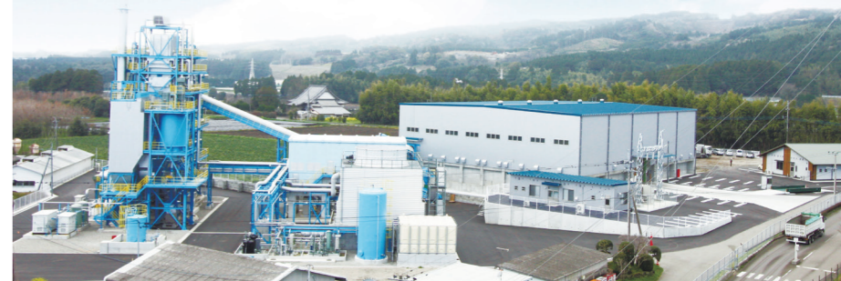
バイオマス発電所外観全景 (住友重機工業株製)
