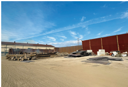
JTRY水島・ガス切ヤード
