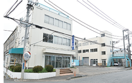
本社事務所・第2工場(神奈川県綾瀬市)
