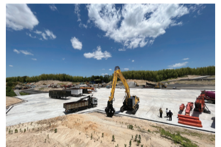
整備が進む岸和田工場(大阪府岸和田市)
